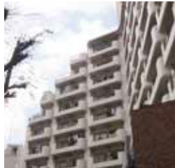
永谷ヒルプラザ六本木 総戸数133戸11階建 昭和47年竣工当時、先取りのな ワンルームマンションとして話題になる
