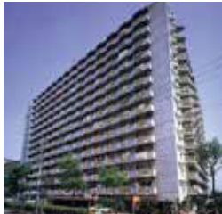
築地永谷コーポラス 総戸数477戸14階建 昭和49年竣工当時、戸数が日本一
